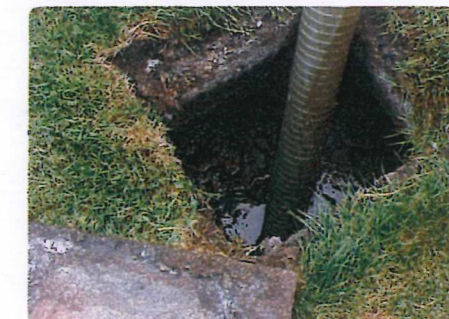
Vidange d'une fosse toutes eaux.
