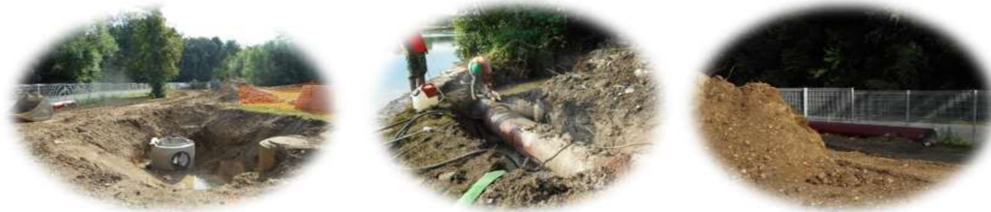
Renouvellement de la canalisation de rejets au Loing de la Station Nemosia
