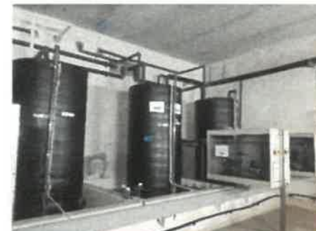
Travaux finalisés et cuves opérationnelles
