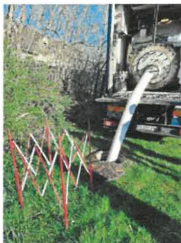
Déploiement de la gaine imprégnée d'une résine par réversion par le bathyscaphe
