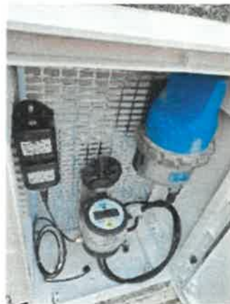
Armoire de départ de l'afficheur et de l'organe de télésurveillance (SOFREL)
