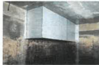
Cloison siphonide installée le 11/05/2023
