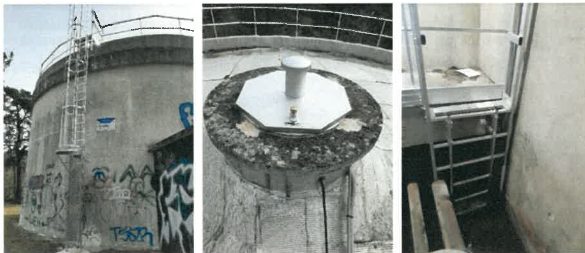
Sécurisation du réservoir de Darvault : échelle d'accès au toit, accès aux vannes, accès à la cuve et bordures du toit
