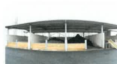
Exemple de hangar de stockage des boues
