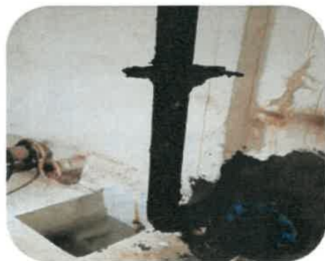
Réservoir de Darvault : peinture écaillée, colonne de trop plein très corrodée
