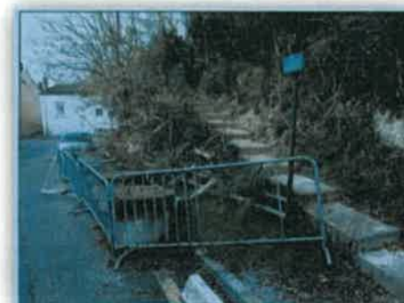
Photo prise après nettoyage de l'escalier – novembre 2021
