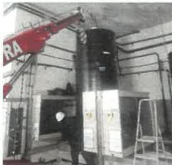
Enlèvement des cuves de stockage des réactifs
