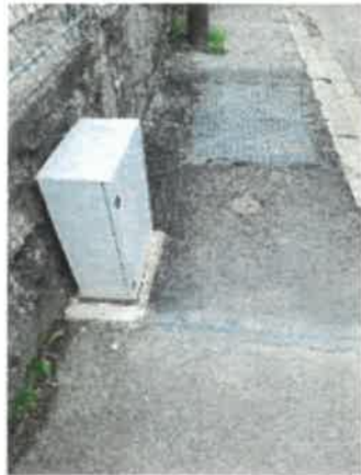
Armoire de départ de l'afficheur et de l'organe de télésurveillance (SOFREL)
