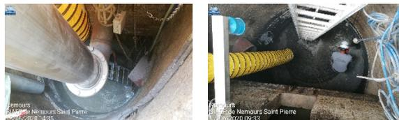
Renouvellement du réseau de collecte des eaux usées (4,5 mètres de profondeur) passant sous l’ancien centre commercial Aldi au Mont St Martin à Nemours – 118 892 € HT
