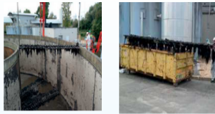
Vidange des bassins de la station NEMOSIA : les rampes d'évacuation sont obstruées par la filace des lingettes.
