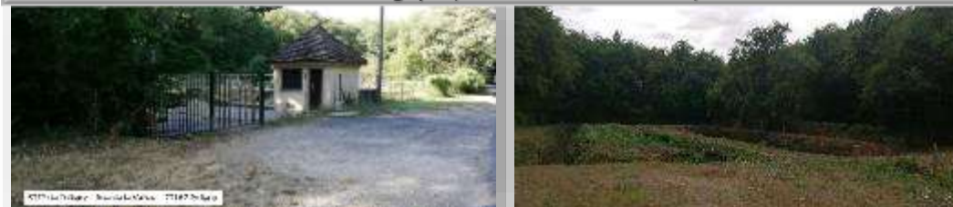
STEP de Poligny - (reconstruction en cours)
