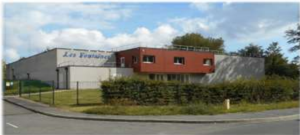
Usine de l'eau « Les Fontaines » Rue de Bagneaux 77140 Saint Pierre Lès Nemours
