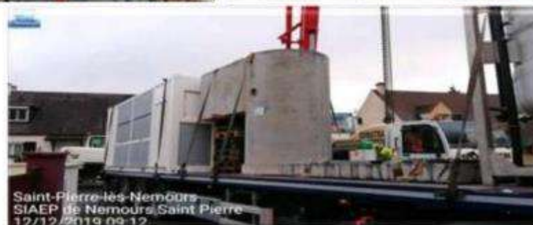
Reprise du réseau et création d'un poste de refoulement à Saint Pierre les Nemours
