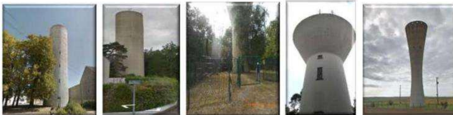
Travaux de sécurisation des 5 réservoirs sur tour
