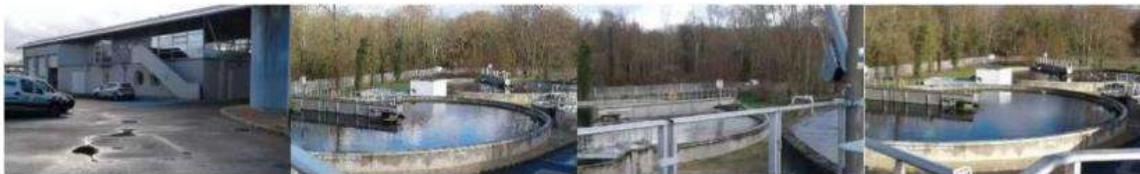
Station de traitement des eaux usées « Nemosia » de Nemours
