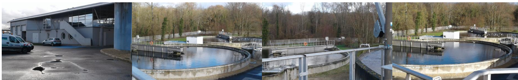
Station de traitement des eaux usées « Nemosa » de Nemours
