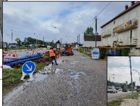
Durant les travaux
