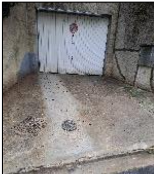
Création d'un branchement au droit du garage, au pied du talus, avec un nouveau compteur.
