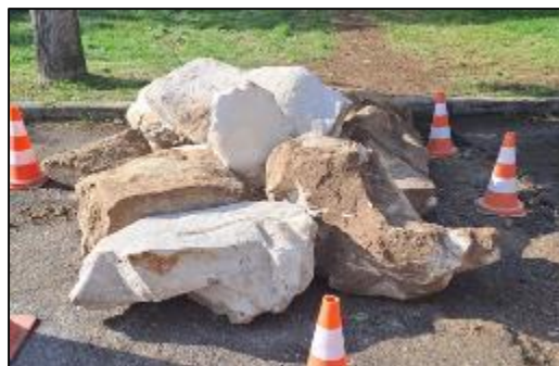
Blocs de roche extraits durant les travaux à l'origine de la découpe en dents de scie de la voirie
