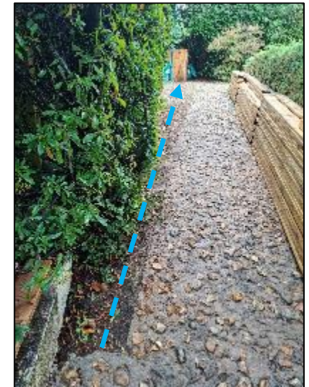
Tranchée au dessus du garage jusqu'à la conduite existante.
