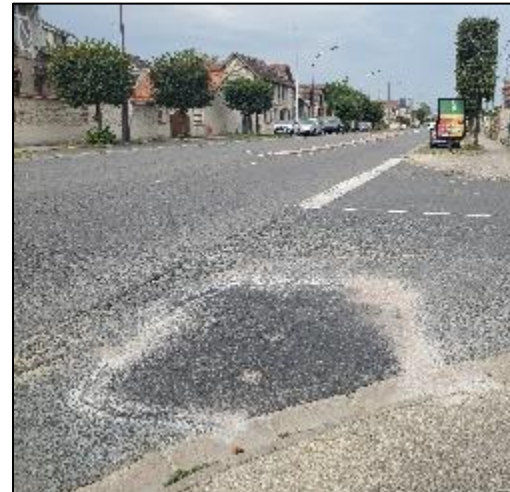
Condamnation de la canalisation au niveau de l'avenue Roux
