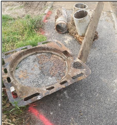
Dépose de la canalisation, du clapet anti-retour et de sa chambre
