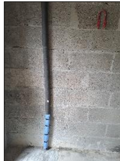
Traversée verticale du garage, protection contre le froid.
