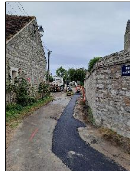
Fin des travaux
