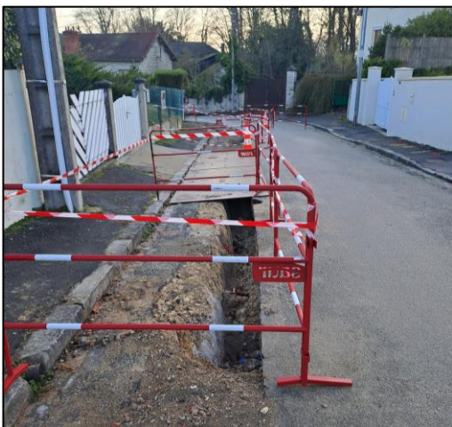
Travaux en cours : 06/12/2023
