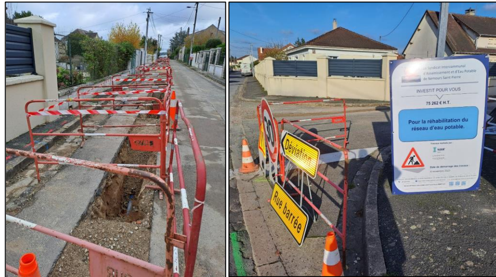
Durant les travaux
