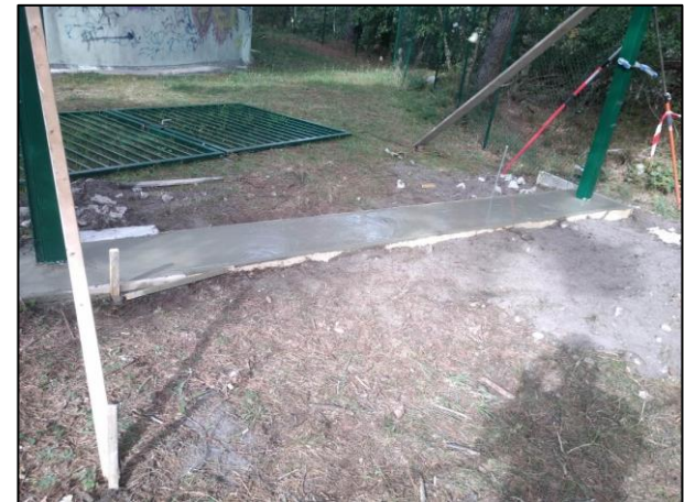
Pendant les travaux
