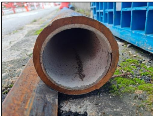
Découpe d'une des canalisations en fonte (DN80)
