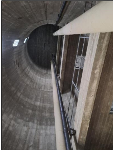
Intérieur du réservoir : échelles et paliers d'accès à la cuve
