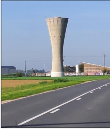
Le réservoir de Châtenoy alimente Châtenoy, Ormesson, Chevrainvilliers et le réservoir d'Aufferville
