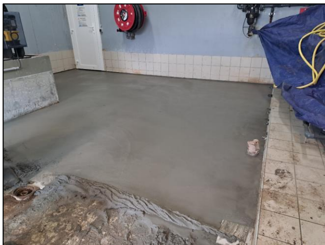
Pendant les travaux
